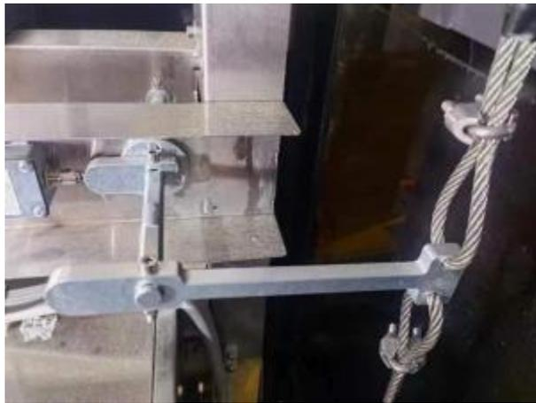
图3 钢丝绳连接示意图（图片供参考）
